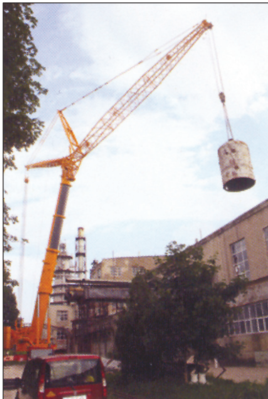
شکل ۳b: نصب بدنه اواپراسیون در فالستی (۲۰۱۰/۰۶/۰۲)
