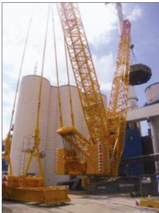
شکل ۱۷: مونتاژ برج دیفوزیون با جرثقیل ۶۰۰ تنی پله‌ای پلات لینگ
