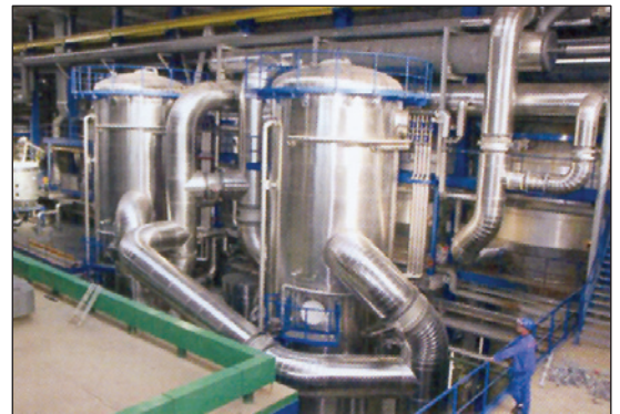
شکل ۱۹: نصب دو دستگاه اواپراسیون ریزشی
