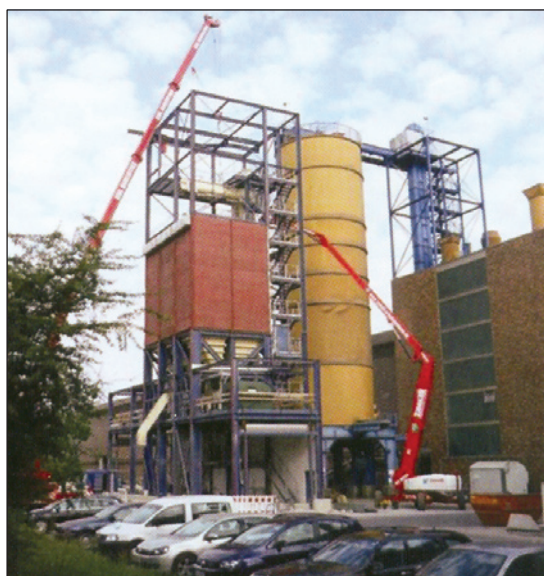
شکل ۱۰: نصب دستگاه بارگیری تفاله خستی در آکسن فورت
