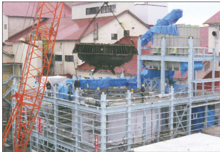
شکل ۱: نصب قسمت انتهایی تفاله خشک‌کن ۱. مقدمه
