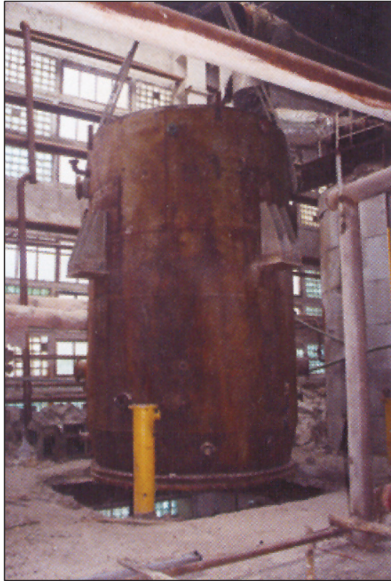
شکل ۳a: پیاده کردن بدنه اواپراسیون در الکساندرن
