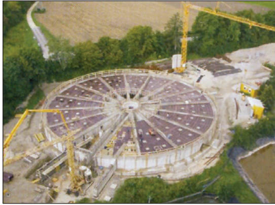
شکل ۲۰: فونداسیون سیلوی شکر ۵۵/۰۰۰ تنی
