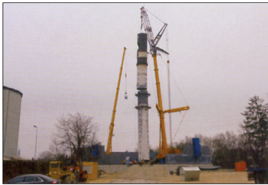
شکل ۲۱: ساخت پایه مرکزی سیلوی شکر
